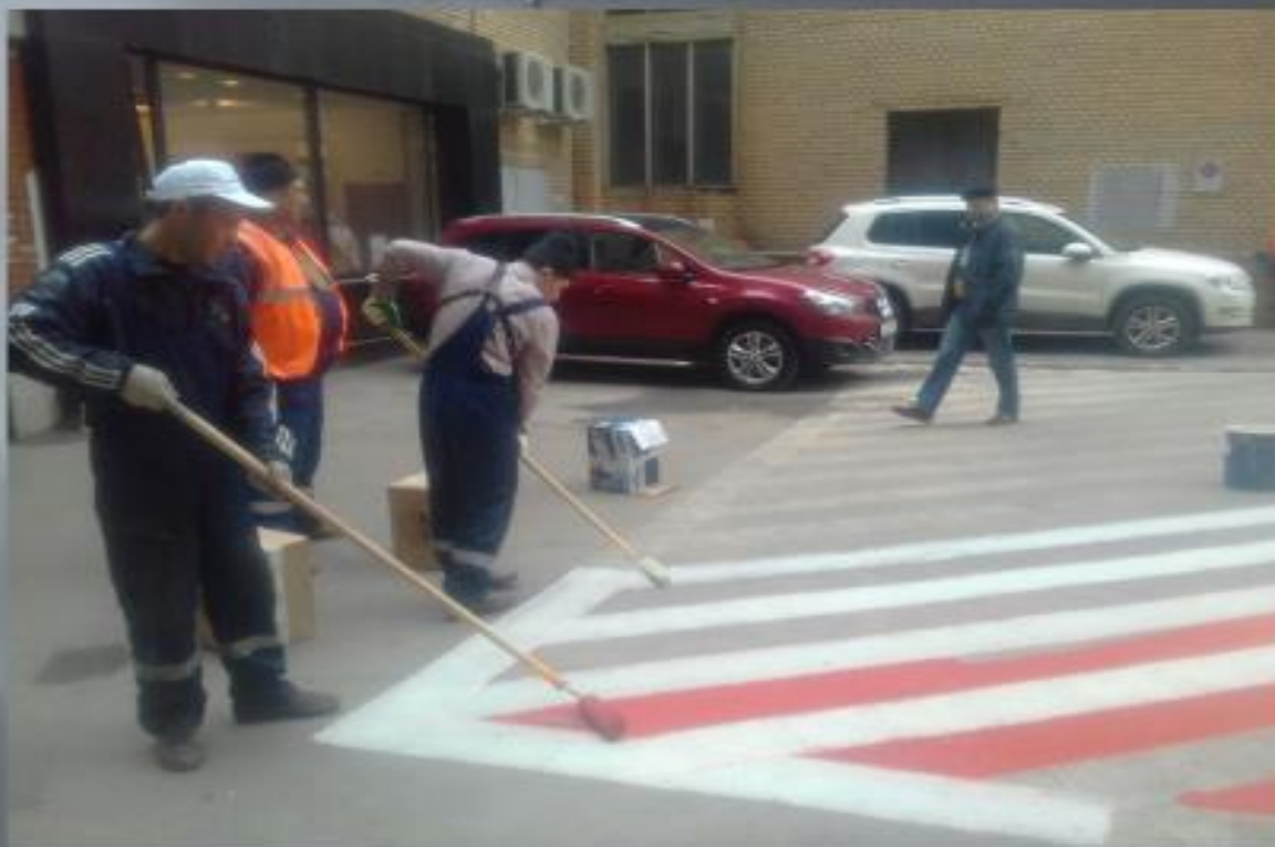
Нанесение разметки площадок для пожарной техники
