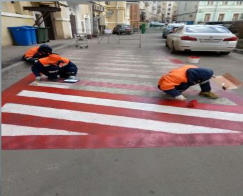
Нанесение разметки площадок для пожарной техники
